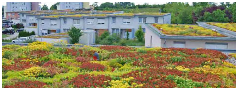
Exemple de toiture terrasse végétalisée
