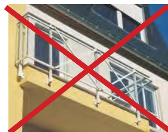
Garde-corps à croisillons
