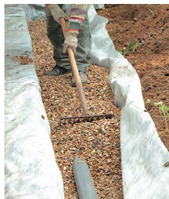
Exemple de tranchée d'infiltration en cours de construction
