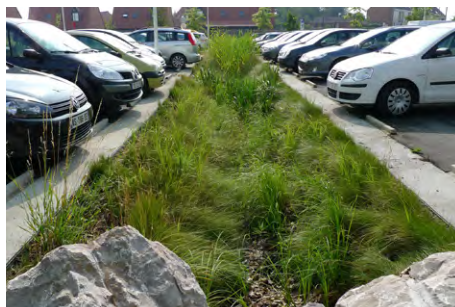
Exemple de noue plantée sur un parking
