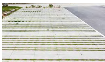
Parking perméable en béton
