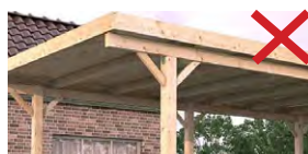
Carport bois - contrefiche apparente non autorisée
