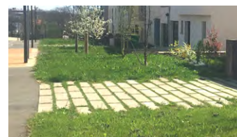
Dalles béton joints enherbés
