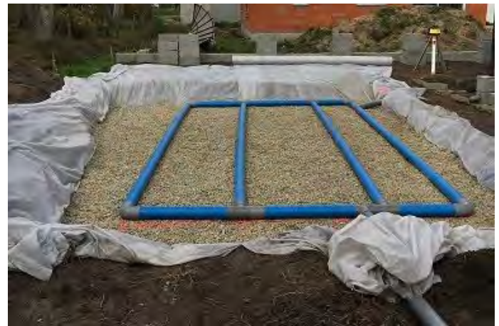
Exemple de massif d'infiltration en cours de construction
