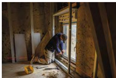
Travaux d'amélioration de l'habitat
